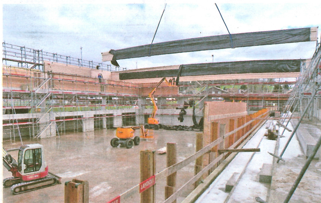
18 Mal schwebt ein Dachträger über den Bauplatz.
