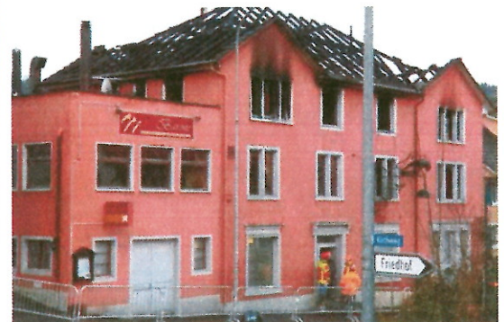
Und 12 Stunden danach: ein ausgebrannter Dachstock und Vollschaten bis ins EG des dreistöckigen Gebäudes. Bild: Kurt Lichtensteiger
